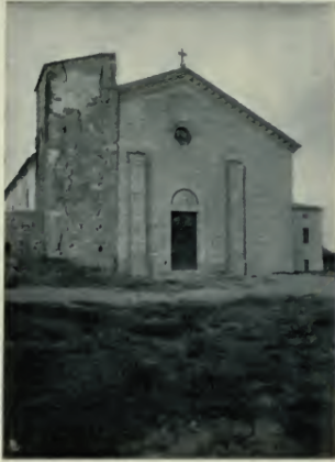
La chiesa di Polenta dopo i primi restauri.
