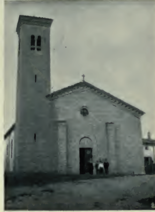
La chiesa di Polenta dopo i secondi restauri.
